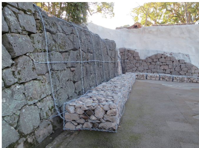
樹脂製ネット設置事例 特別史跡熊本城跡(熊本市)
