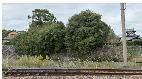
石垣 (No.101 ~ 103 面：陣甫曲輪東側) 天端近くに生育している広葉樹
