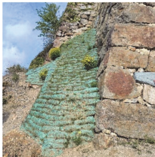
押さえ盛土事例 史跡洲本城後(兵庫県洲本市)
