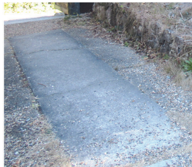
コンクリート舗装
