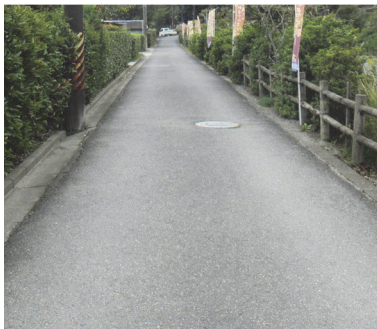
アスファルト舗装
