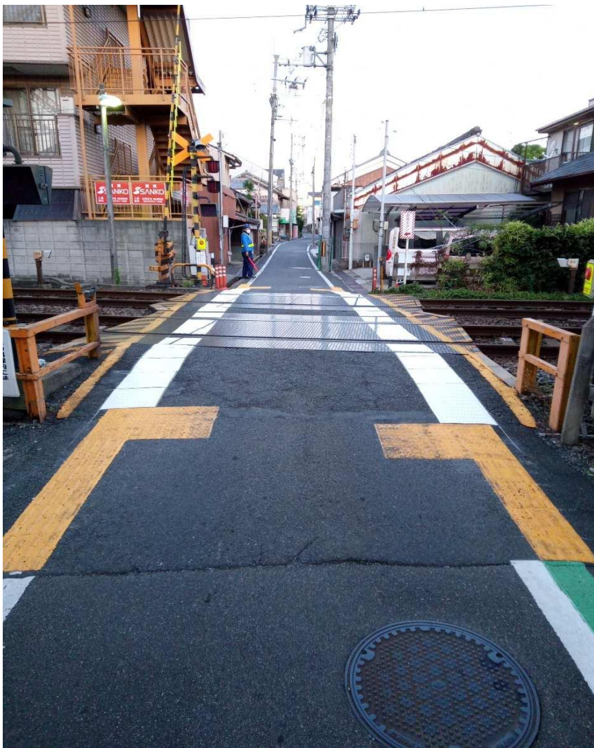
郡山第2号踏切内 誘導用点字シート設置後
