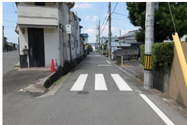
現況写真 (東側から対象路線を望む)
