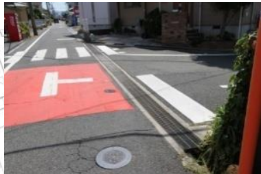
現況写真 (事業 No.2 実施範囲)
