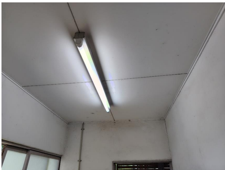
男子トイレ 点検口設置部天井
