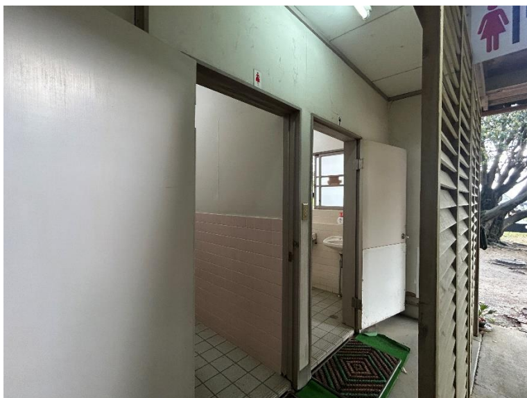
トイレ出入口
