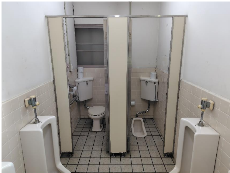
男子トイレ トイレブース
