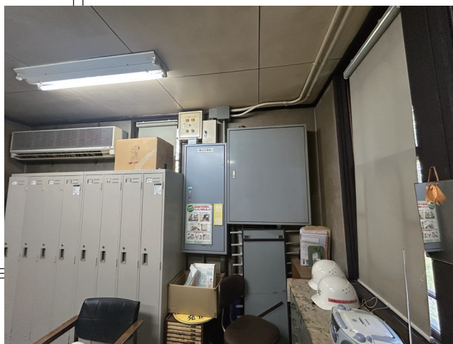
既設分電盤周辺 近接位置に分電盤を新設
