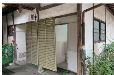
城址会館横のトイレ
