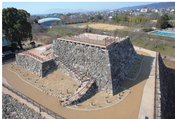
整備された天守台と展望施設
