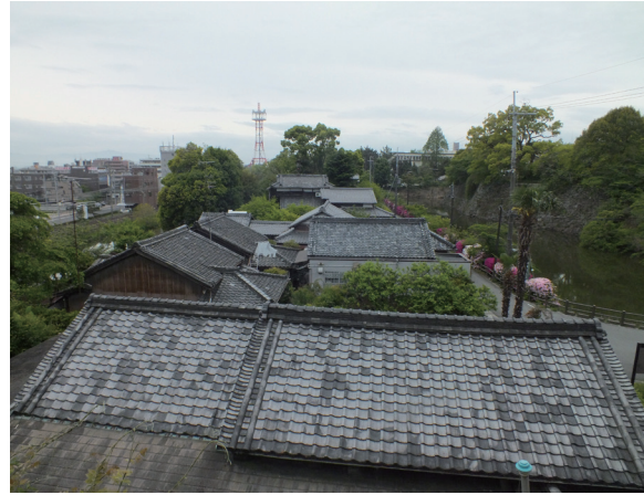
指定地内の住宅地（陣甫曲輪）
