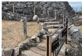
No. 4: 階段・手すり
