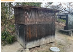
No. 6: ポンプ小屋
