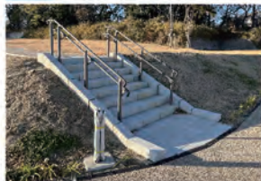
No. 3 : 階段・手すり
