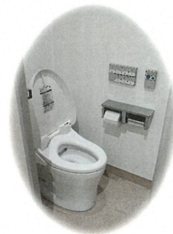
小学校の改修されたトイレ
