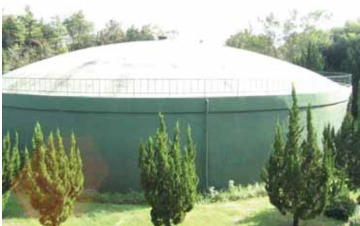
◆ 矢田山第3配水池 ◆
