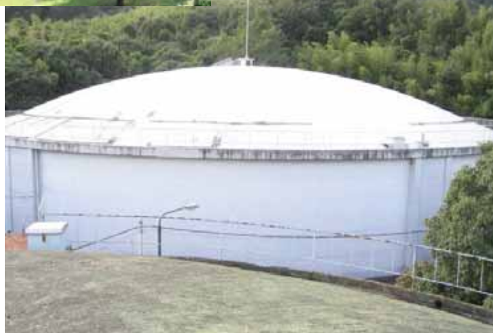
◆ 矢田山第4配水池 ◆
