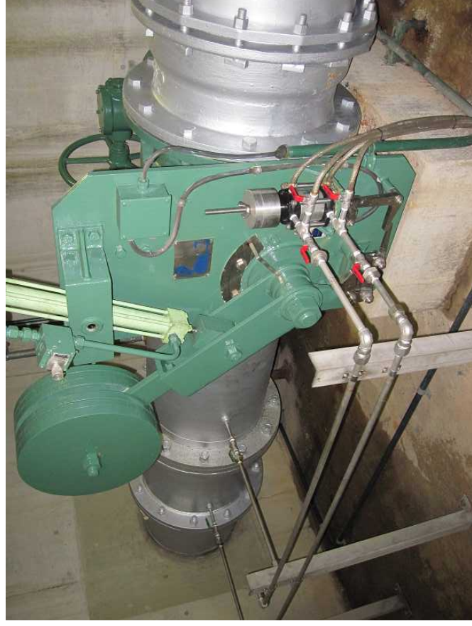
φ500 ウェイト式 緊急遮断弁
