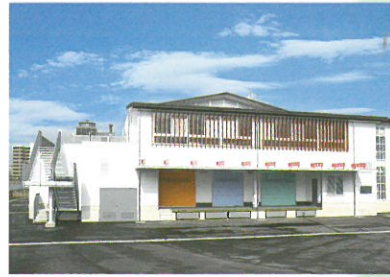
南側 荷受プラットフォーム
