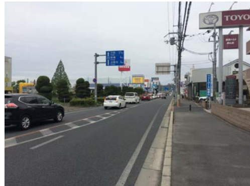
図：歩道の整備例（一般国道25号）
