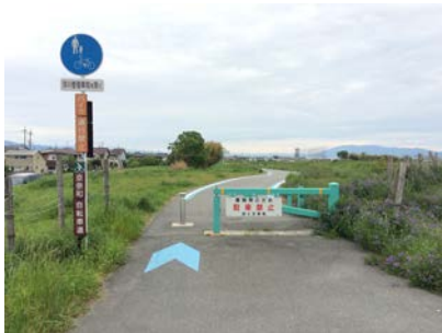
図：自転車道の整備例（京奈和自転車道）
