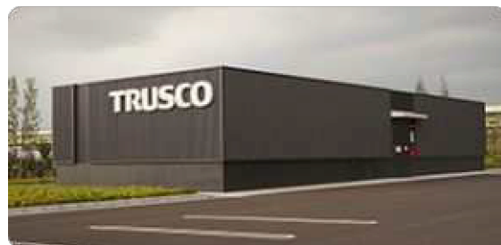
全プラネットに設置されている危険物倉庫
