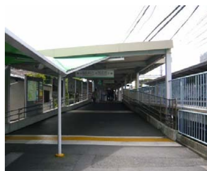
写真 6-2 近鉄郡山駅の下りホームスロープ
