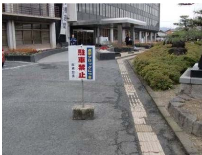
写真 6-25 出入口付近の視覚障害者誘導用ブロック
