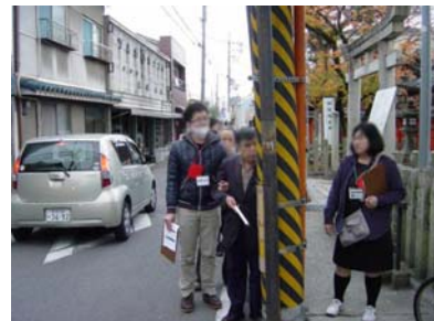
写真 3-22 大和郡山上三橋線の調査状況(2)
