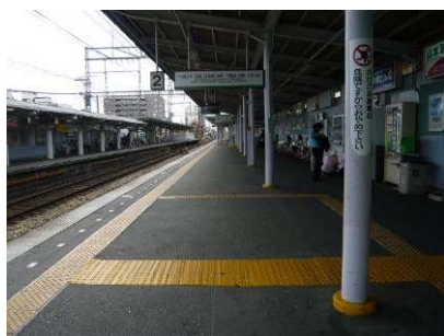
写真 3-3 ホームの状況
