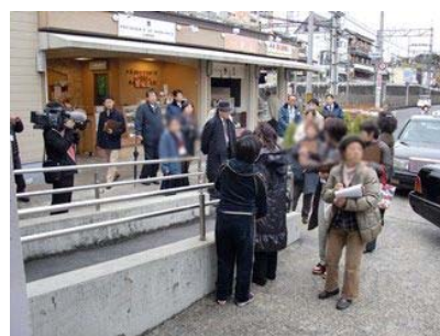
写真 3-1 東改札出口付近スロープの調査状況
