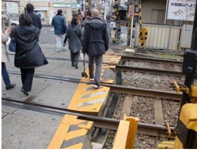
写真 3-36 九条第 12 号踏切の調査状況
