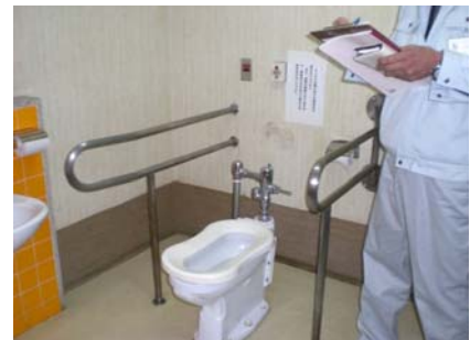
写真 3-16 多目的トイレの調査状況
