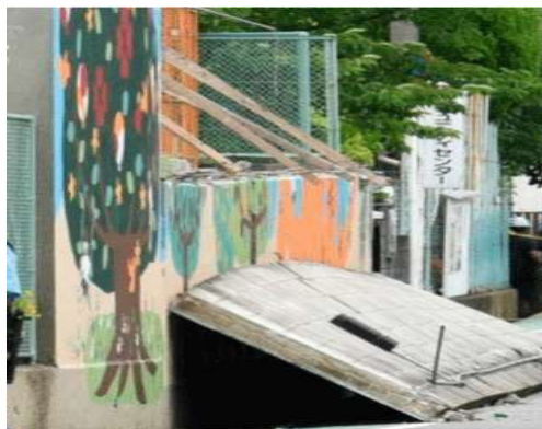
写真 3-4-1 大阪府北部を震源とする地震によるブロック塀の倒壊
