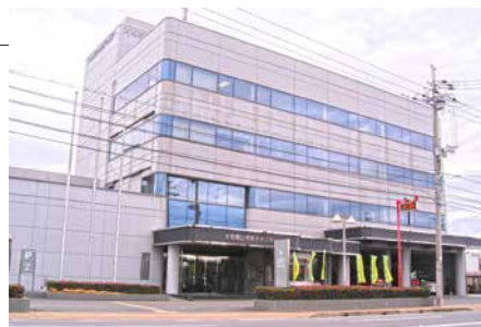
防災センター
