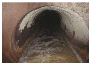
下水道施設の更新前
