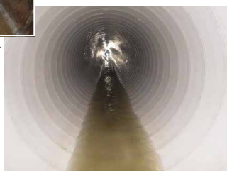
下水道施設の更新後
