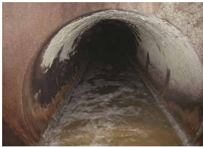
下水道施設の更新前
