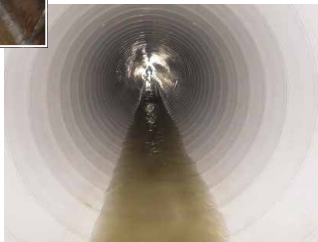
下水道施設の更新後
