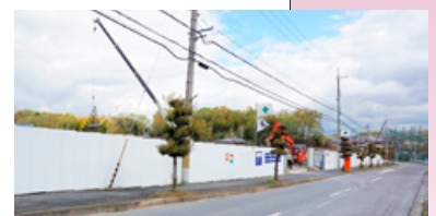
建設中の(仮称)矢田認定こども園
