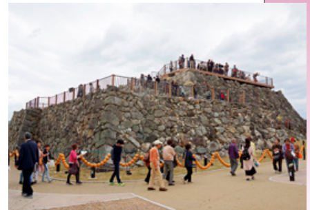
郡山城天守台展望施設
