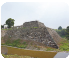
完成間近の天守台
