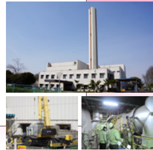
長寿命化の工事がすすむ清掃センター
